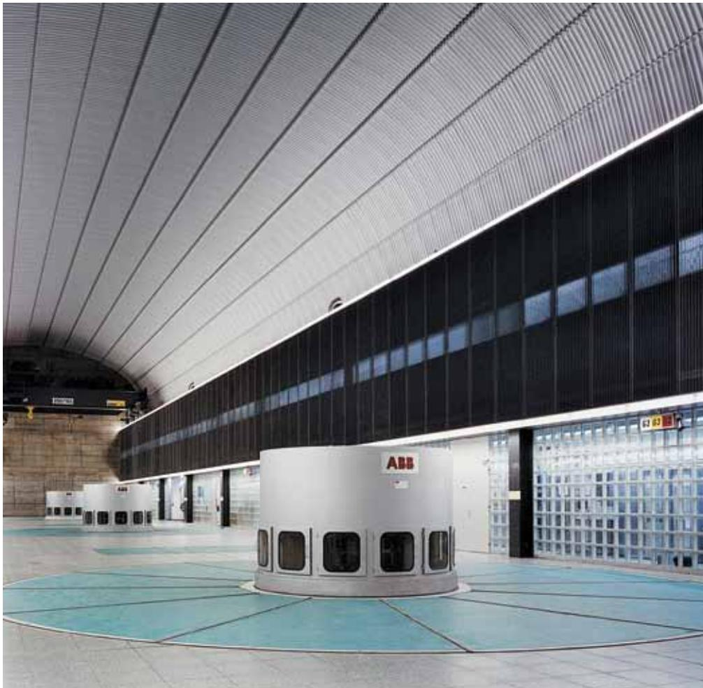
Die in der Nähe des bestehenden Kraftwerks Nendaz (Grande Dixence) gelegene Hauptkaverne des Kraftwerks Bieudron ist über 100 m lang, 39 m hoch und 25 m breit. Das Kraftwerk besteht aus insgesamt 3 Kavernen und mehreren Zugangs- und Verbindungsstollen, die einem Aushubvolumen von 150'000 m<sup>3</sup> entspricht.
