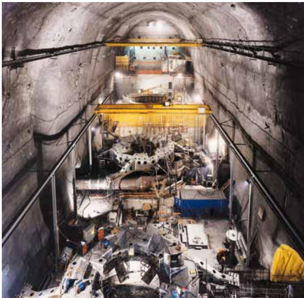
Les trois centrales existantes de Chandoline, Fionnay et Nendaz, d'une puissance de 800 MW, requièrent 2200 heures pour turbiner les 400 millions de m<sup>3</sup> d'eau accumulables dans la retenue de Grande Dixence.
