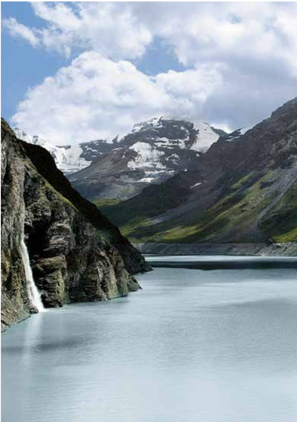
Le Val des Dix, en amont du barrage
