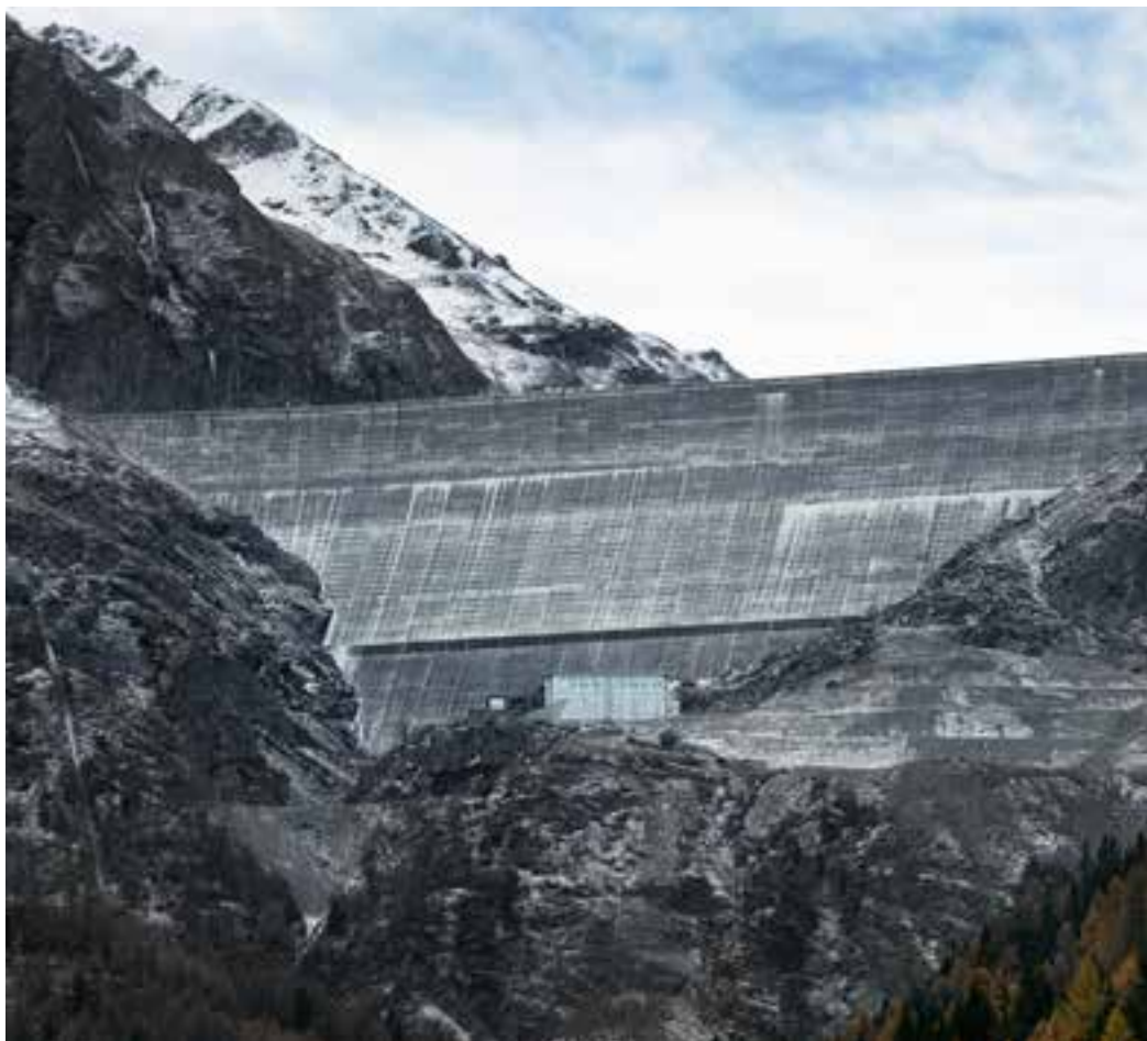
Le barrage-poids le plus haut du monde
