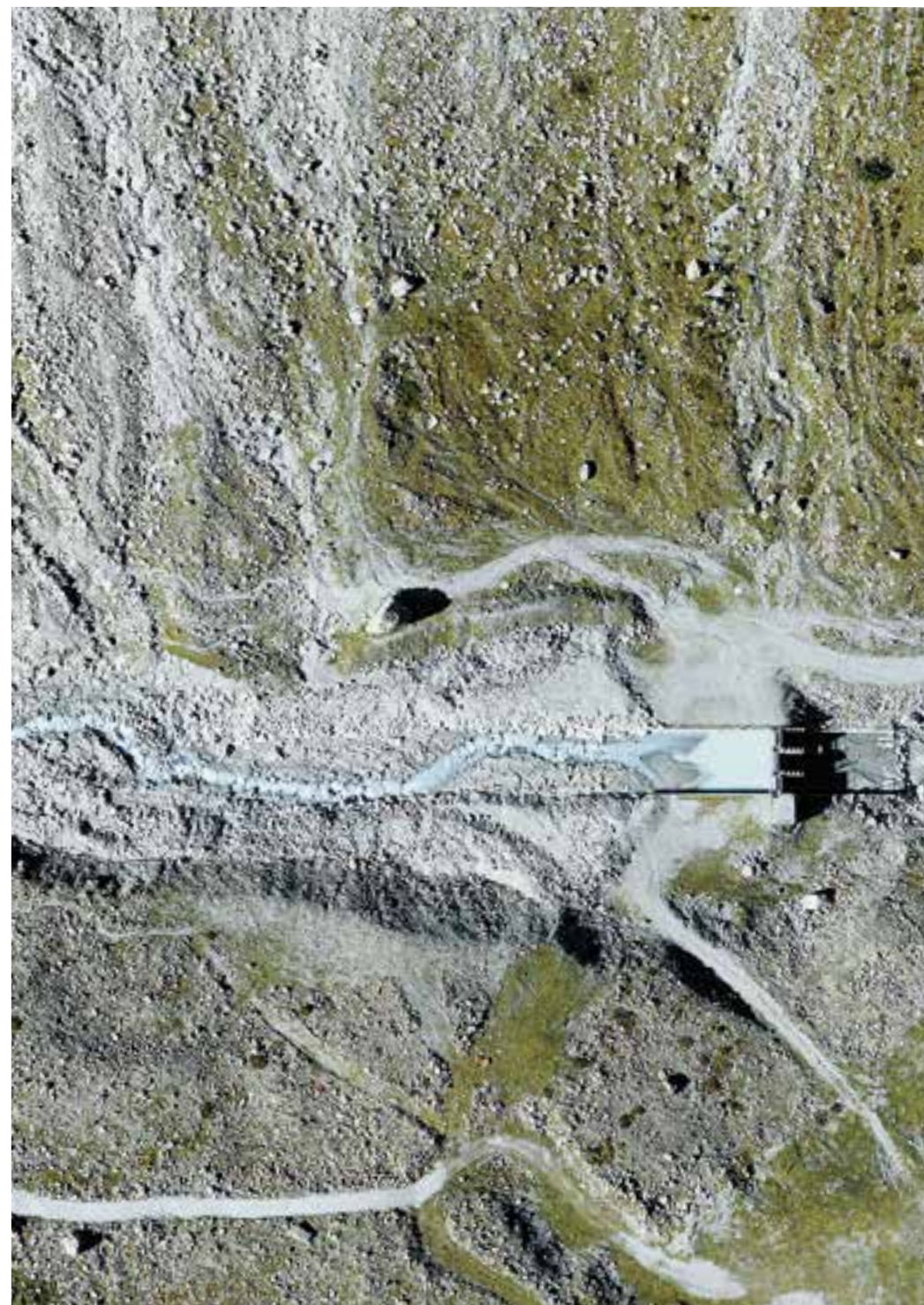
Prise d'eau de Bertol inférieur
