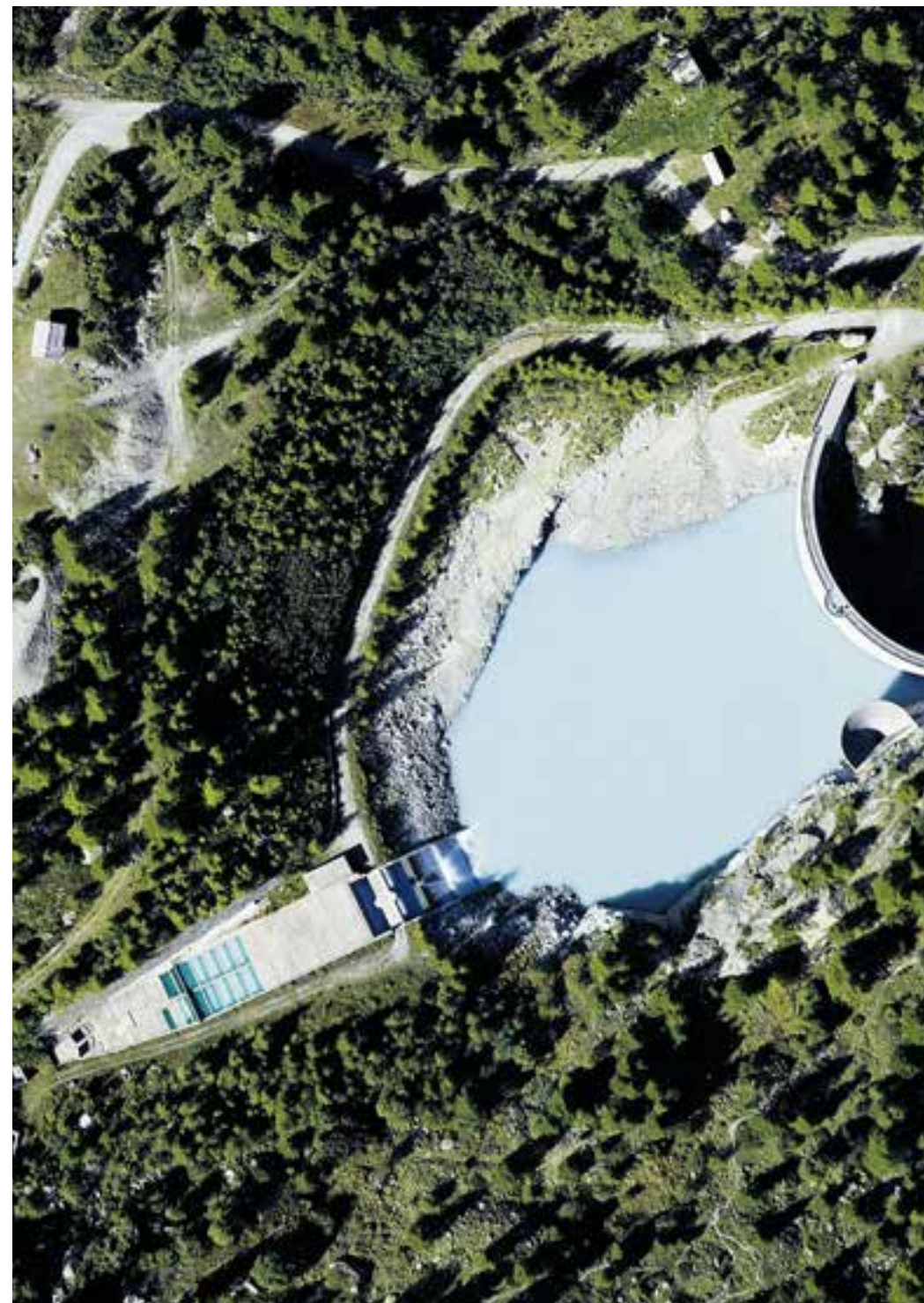
Prise d'eau de la station de pompage de Ferpèche
