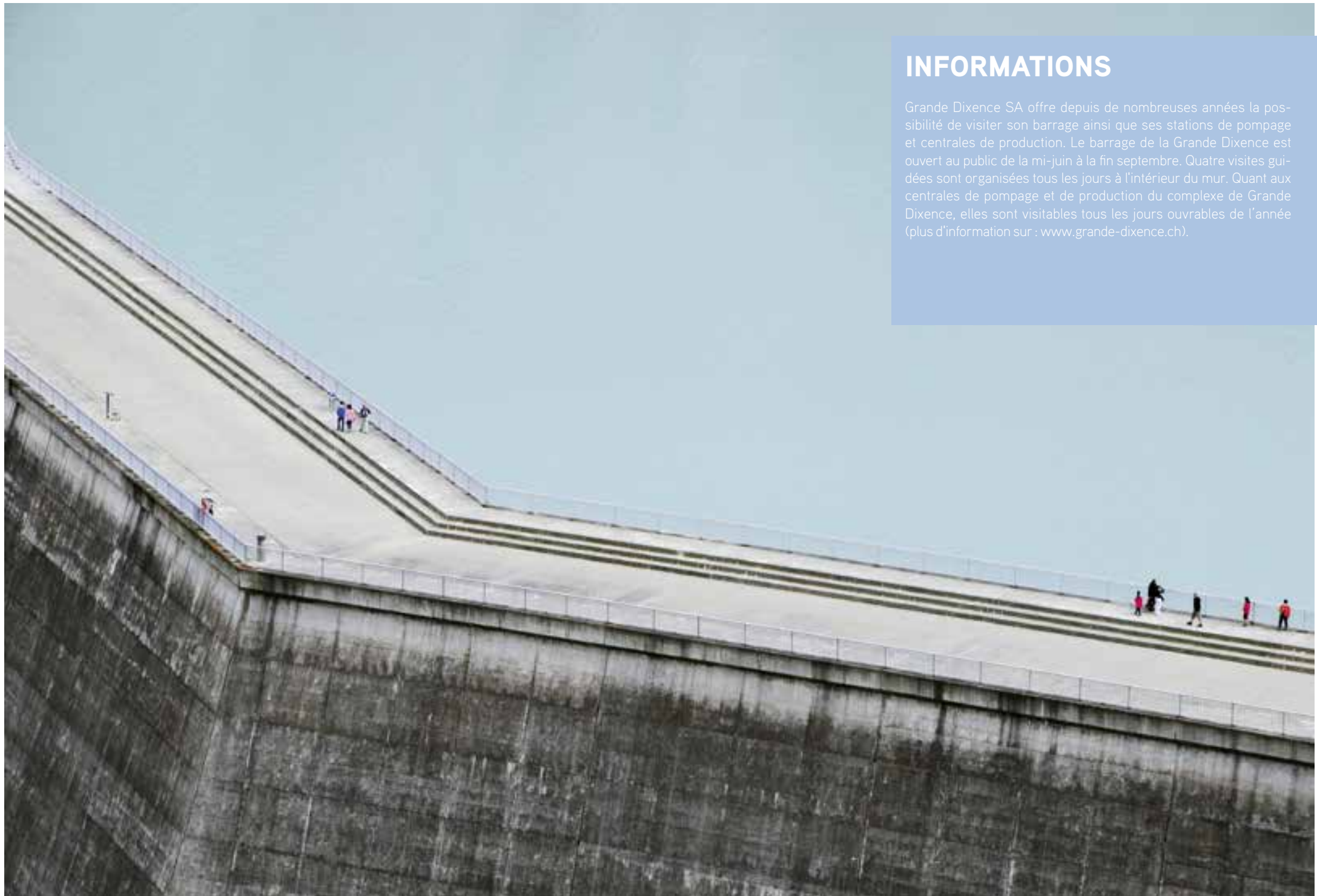
Le couronnement du barrage de la Grande Dixence, point de départ de nombreuses balades en montagne
