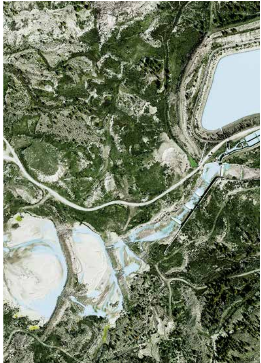
Dessableurs de la station de pompage de Stafel
