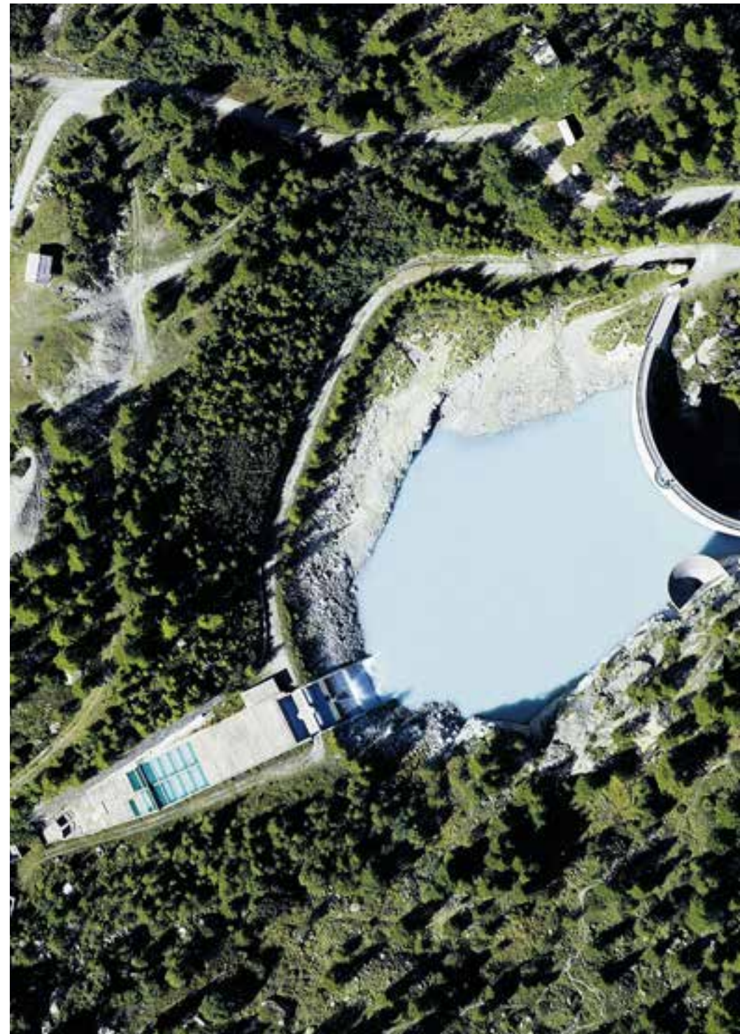
Wasserfassung der Pumpstation Ferpècle
