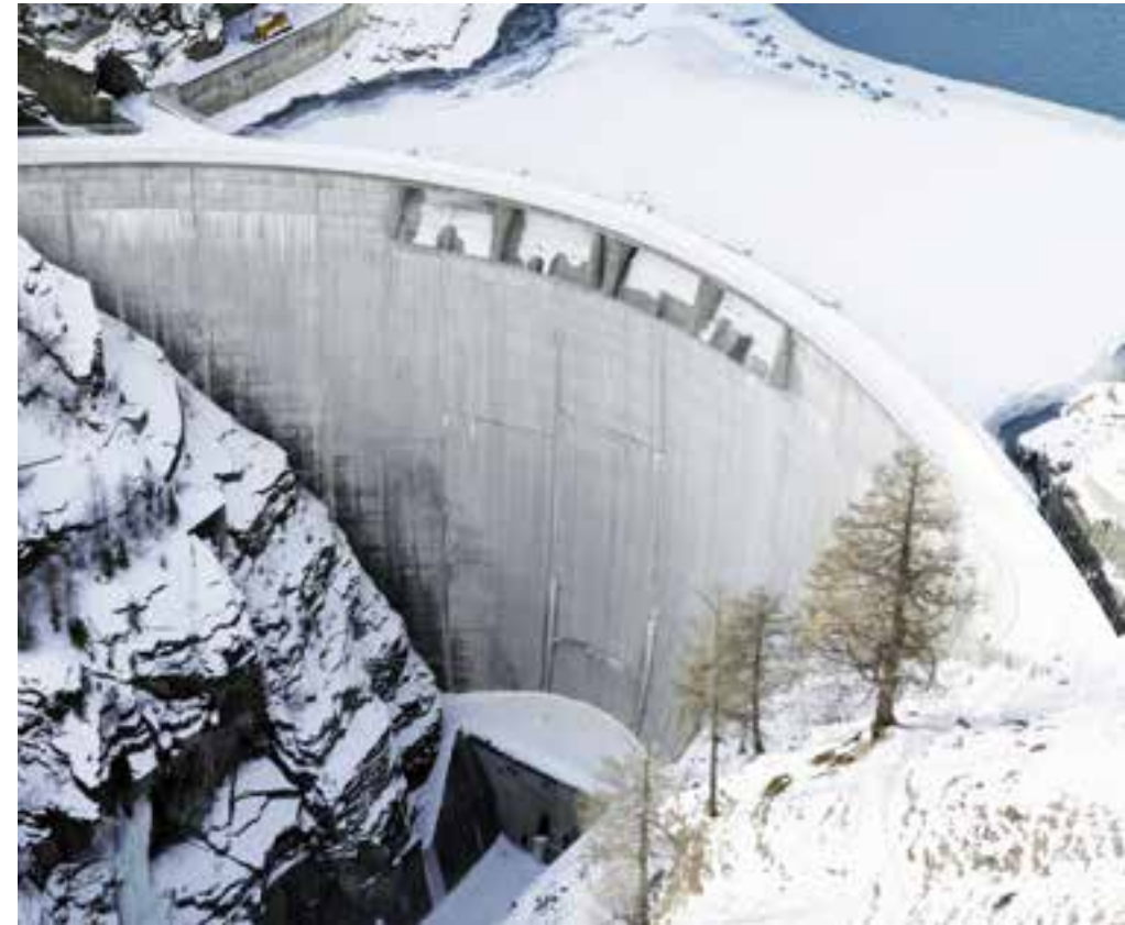
Bogenstaumauer Z'Mutt, weit hinten im Mattertal
