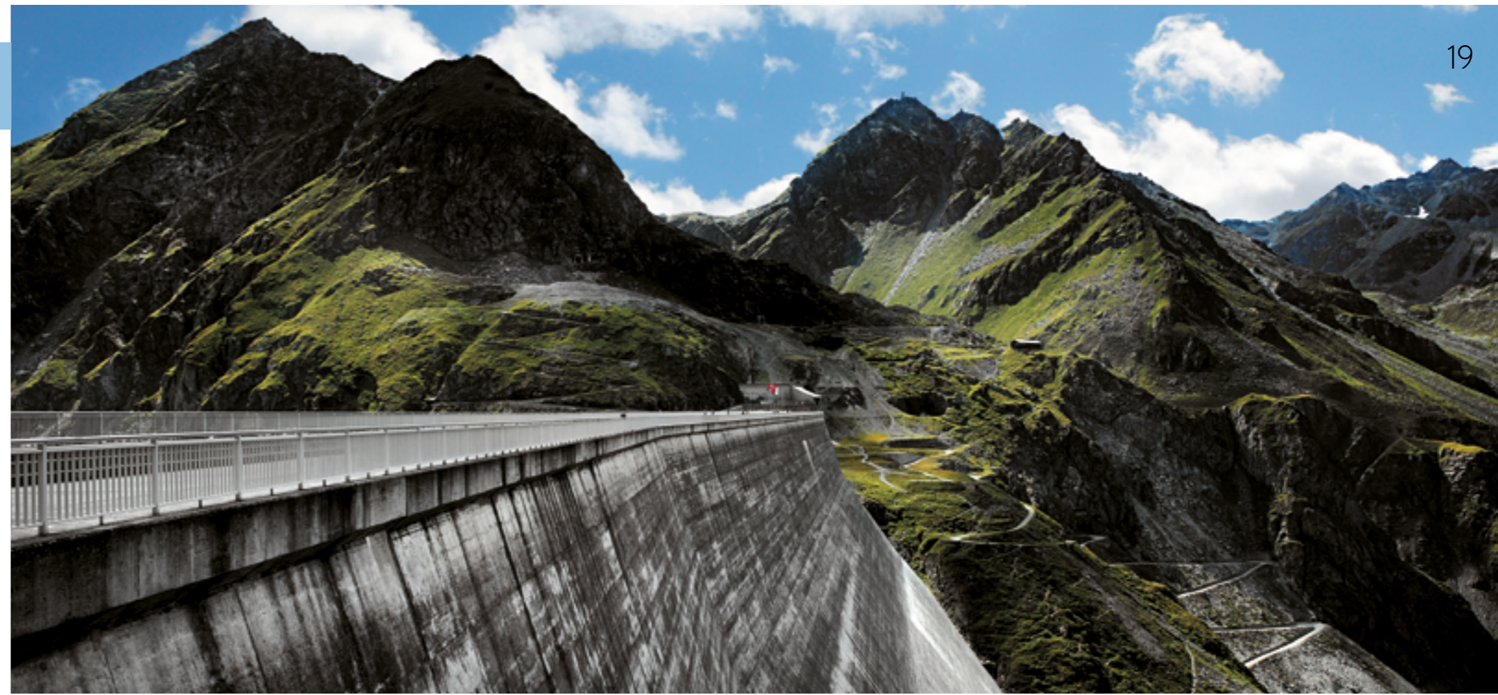
Promenade sur le couronnement
