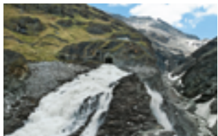
Arrivée du collecteur dans le Lac des Dix à Cheillon
