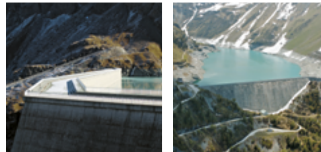
Les lacs artificiels des Dix (à gauche) et de Cleuson (à droite) sont la clé de voûte du complexe de Grande Dixence
