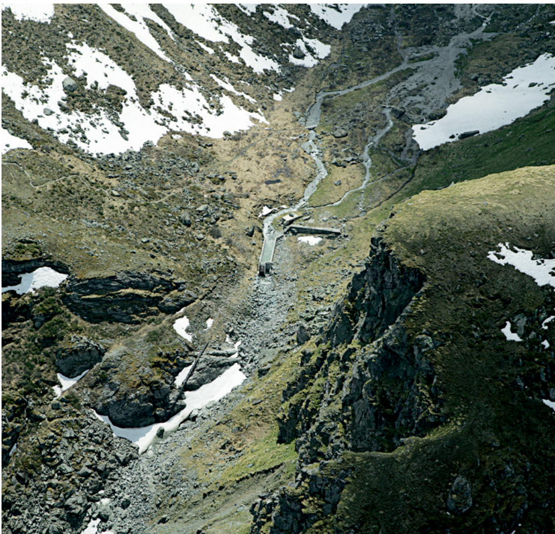
Prise d'eau au fond de la combe de Prafleuri.
