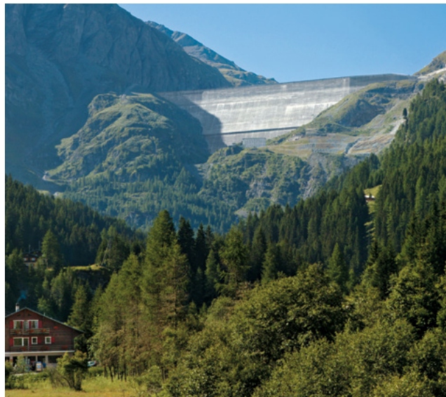
Grande Dixence, le plus haut barrage-poids du monde.
