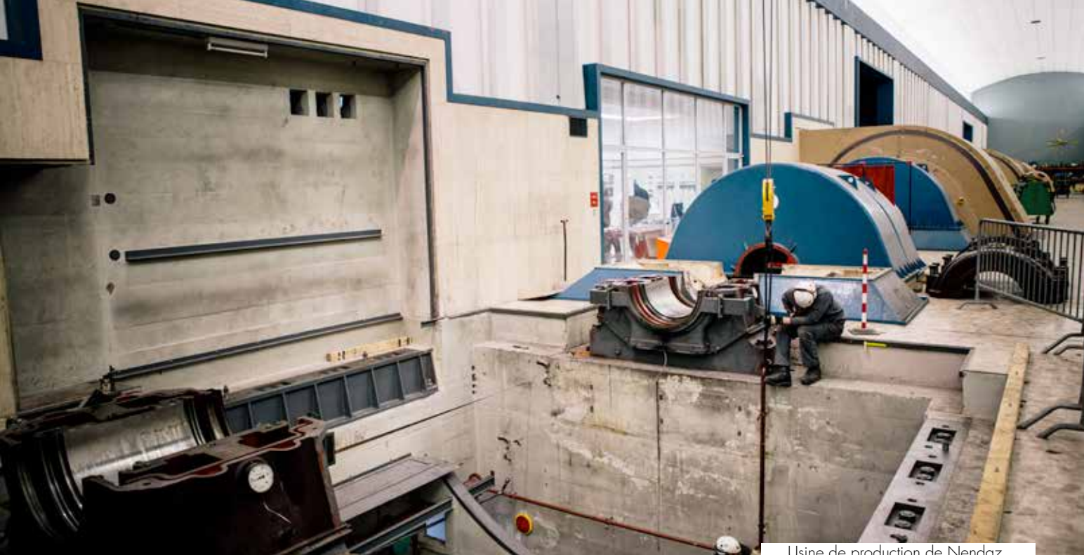
Usine de production de Nendaz
